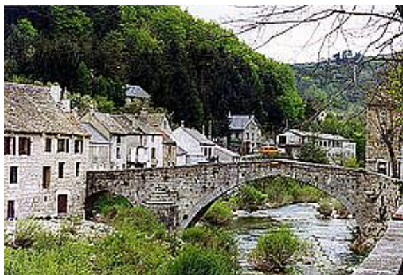
Le Pont-de-Montvert (Cevennes)
